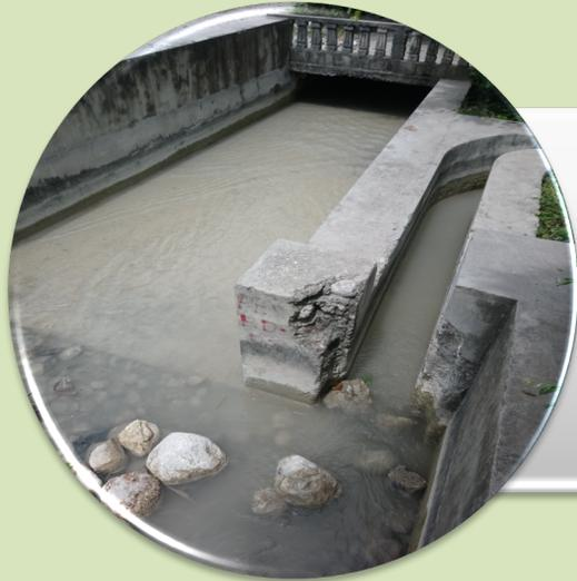
13 prises au niveau des canaux primaires des servant les secondaires nécessitant des vannes
